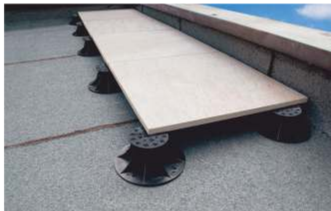
Строительство настилов и полов на эксплуатируемых кровлях.
