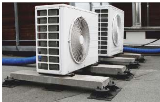
Установка оборудования в строго горизонтальном положении.
