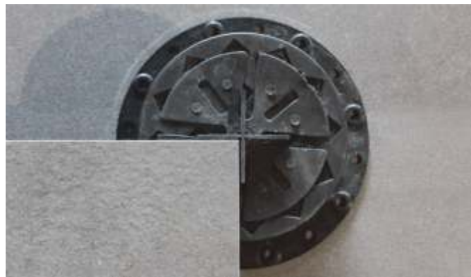
Расположение угла плитки на вершине регулируемой опоры.
