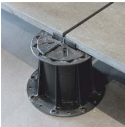
Монтаж на регулируемые опоры
