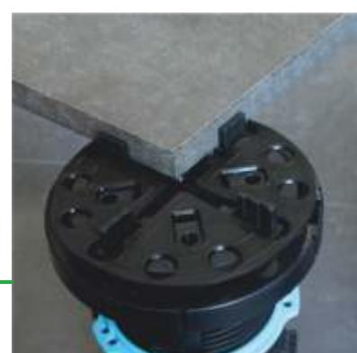
Укладка керамогранитной плитки на вершины регулируемых опор
