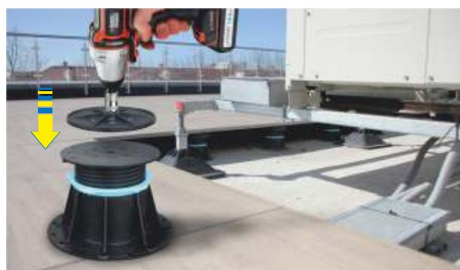
Насадка фиксируется к шуруповерту при помощи шестигранной головки 14 мм и прикладывается к вершине.
