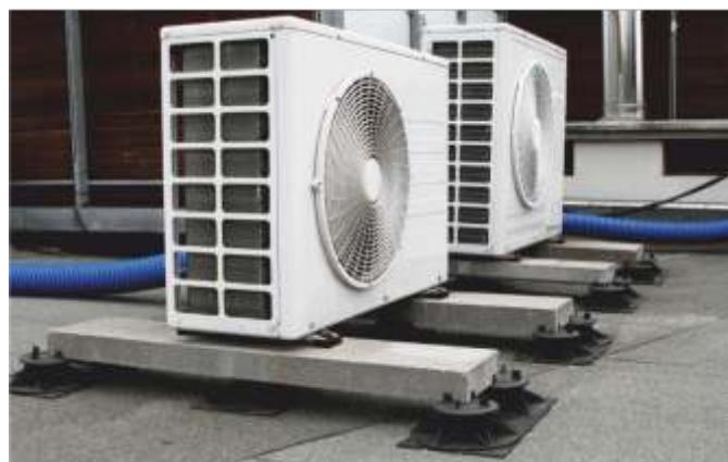
Установка оборудования в строго горизонтальном положении.
