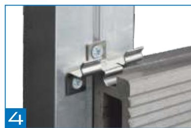
Для монтажа всех последующих досок на торце используется промежуточный кляймер, который обеспечивает равномерный зазор.
