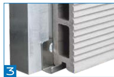
В основание торцевой лаги крепится стартовый крепеж KRONEK для скрытого монтажа, который надежно прижимает доску.
